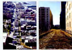
도시 건물들 사이로 보이는 하이라인철도 / 훌륭스럽게 버려진 하이라인 철도
